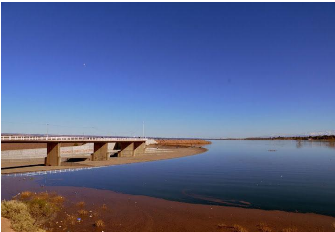
Figura N° 38: Presa Embalse El Carrizal. Departamento de Rivadavia. Año 2015.
